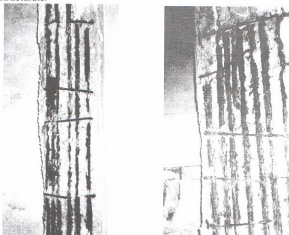
Foto 1: Aspecte de stâlpi, secția Fierbătorie și Albitorie, la cota \pm 0,00 și + 13,50
