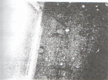
Fig. 1. Depozit de sulf – aspect consolă șir A ax 4
