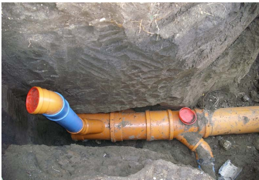
Fig. 2 – Capătul colectorului spre centrala de tratare a aerului
