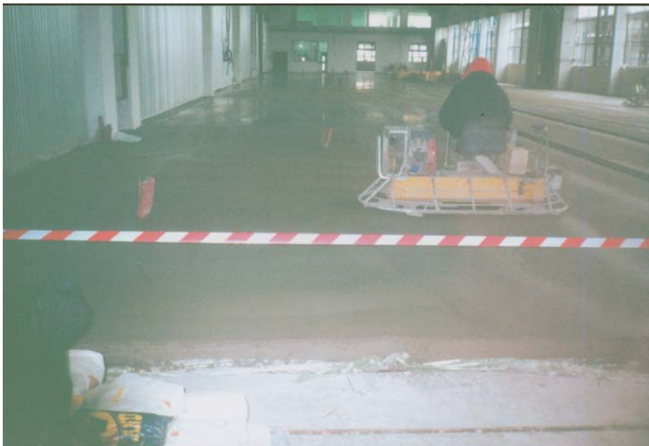
Fig. 12. Prelucrarea prin elicopterizare a suprafeței pardoselii din beton
