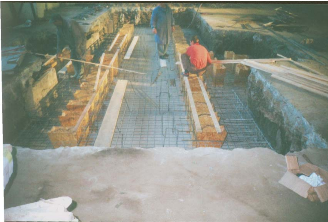
Fig. 10. Poziționarea cutiilor din lemn pentru realizarea golurilor de fixare a buloanelor de montaj
