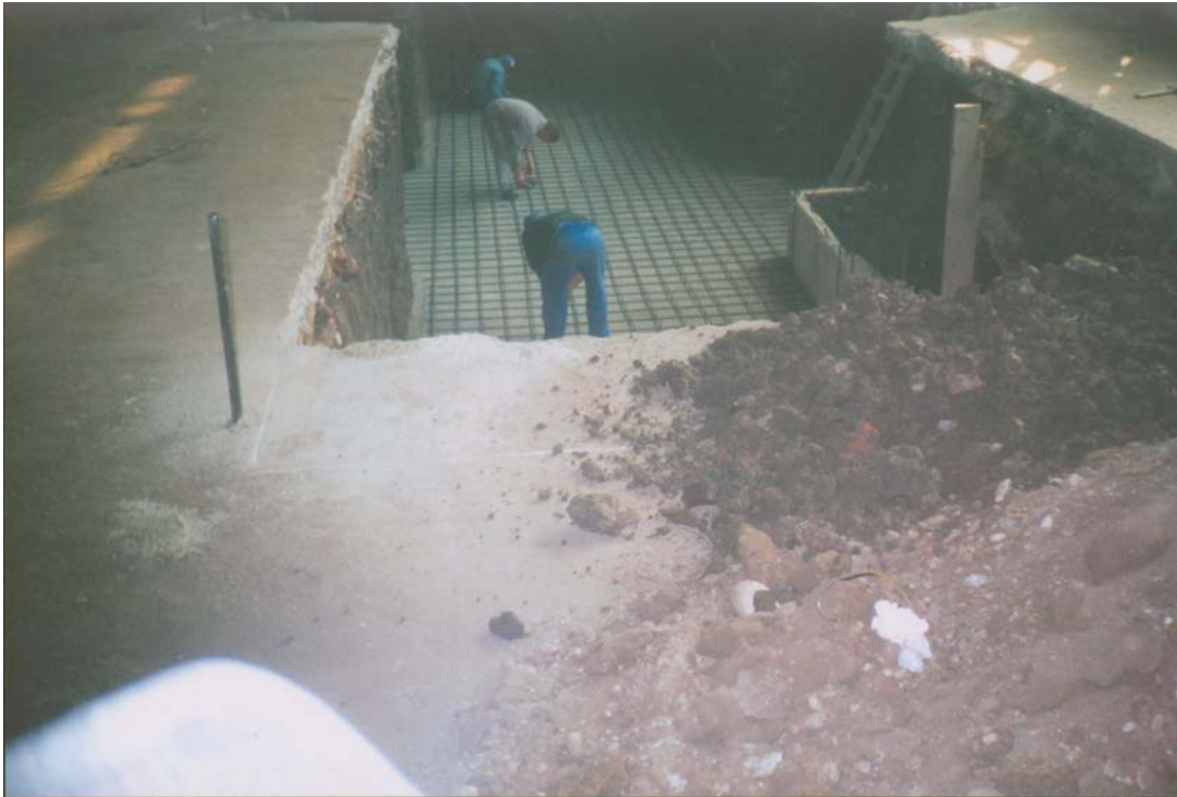
Fig. 9. Armare radier fundație freză
