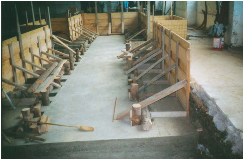
Fig. 11. Cofrare și armare perete cuvă
